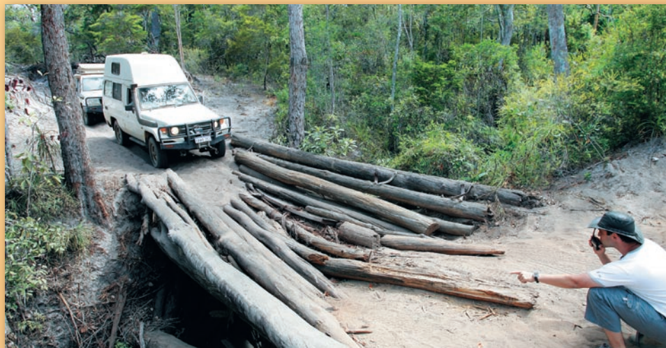
Gewagter Brückenbau: Die Überquerung mit Funkführung hat sich bestens bewährt.
